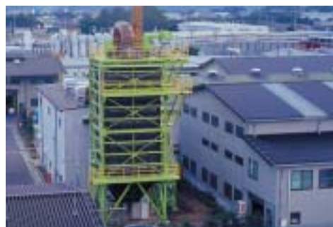
排ガス処理設備 ：ダイオキシンの発生を厳しく抑えた排ガス処理設備。厳しく強化される環境法規制に対応し、循環型社会の形成に貢献しています。
